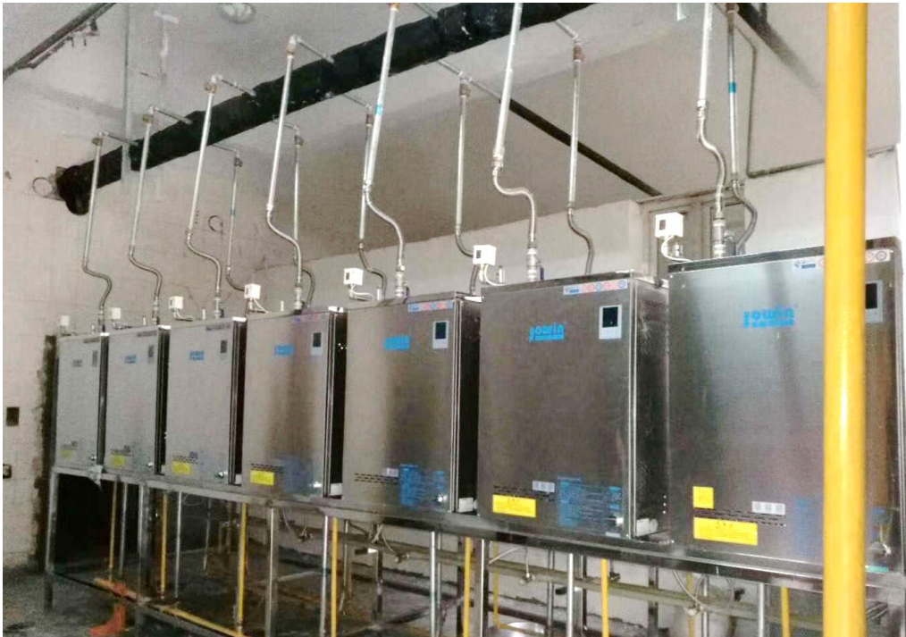
图 16 使用波纹管的连接方式
